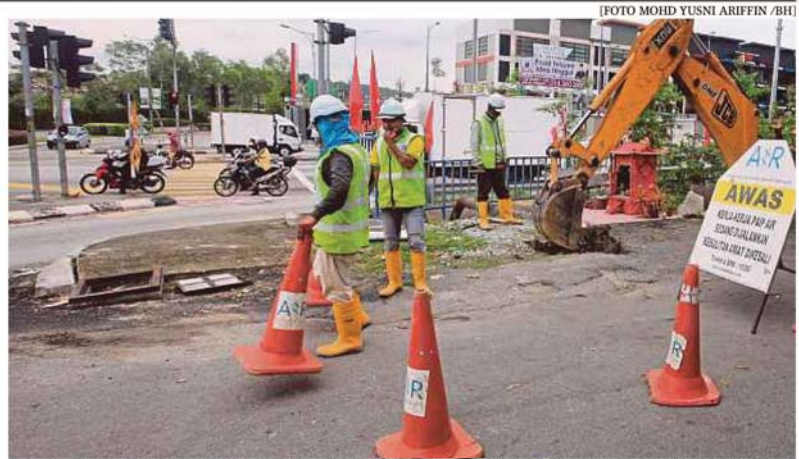
Pekerja Kontraktor Air Selangor ketika menjalankan kerja menyelenggara paip utama di Jalan Aik Ann 1, Taman Aik Ann, Semenyih.
